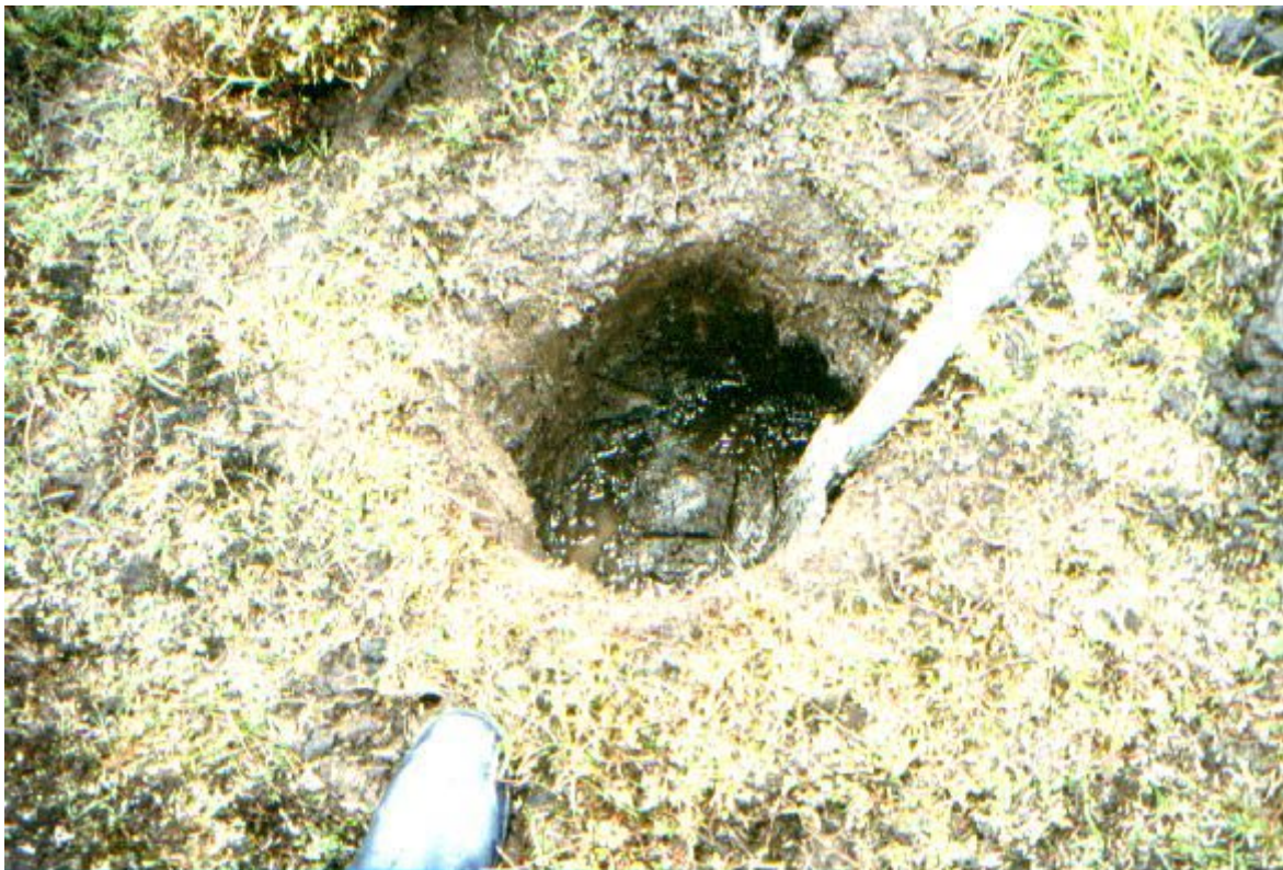
Loch im Permafrostboden
